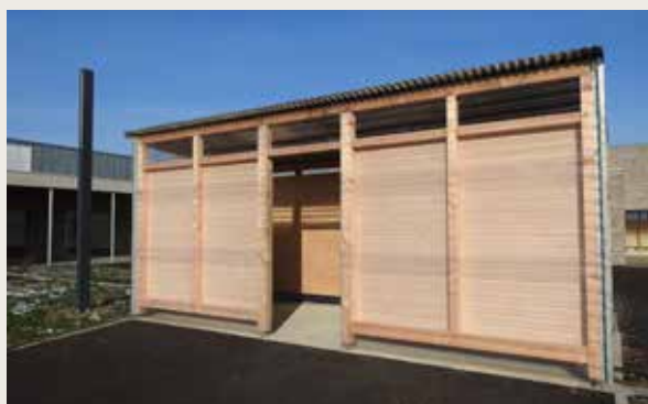
Bungalow pour mettre à l'abri le matériel
